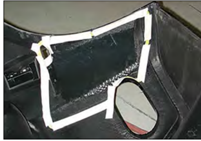
Delimitar zona reparada
